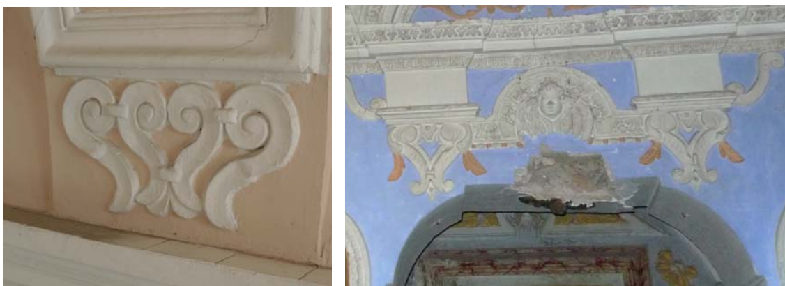
Figura 27. I capitelli dei peducci delle volte della chiesa di San Michele (a sinistra) e quelli di San Donato (a destra).
