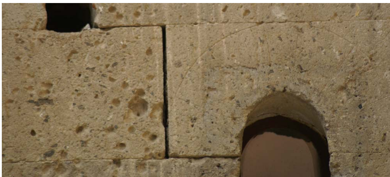
Figura 6. Particolare del concio d'arco della monofora aperta sulla facciata laterale verso sud della chiesa di San Pietro.
