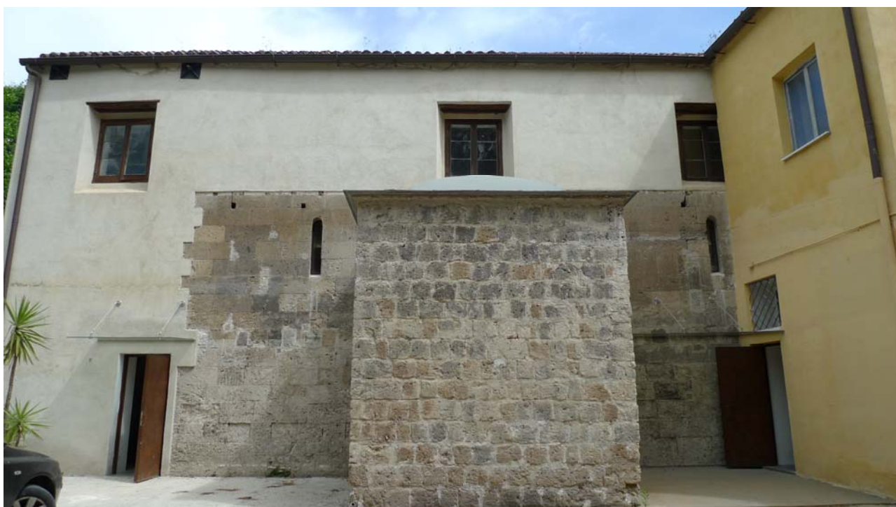
Figura 4. La facciata laterale verso sud della chiesa di San Pietro.
