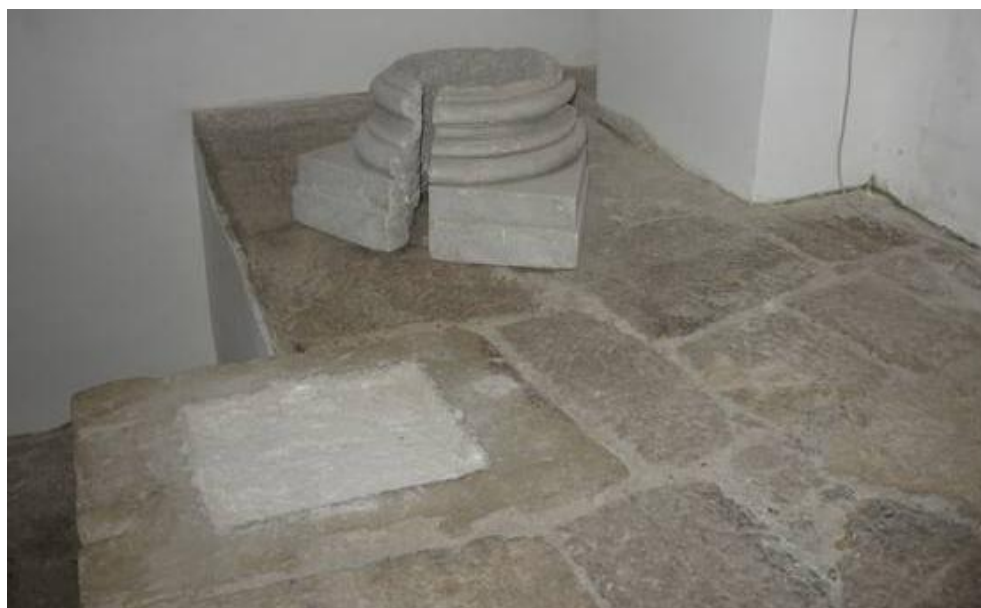
Figura 12. Teano, cattedrale, scala di ingresso alla cripta, materiali di riuso
