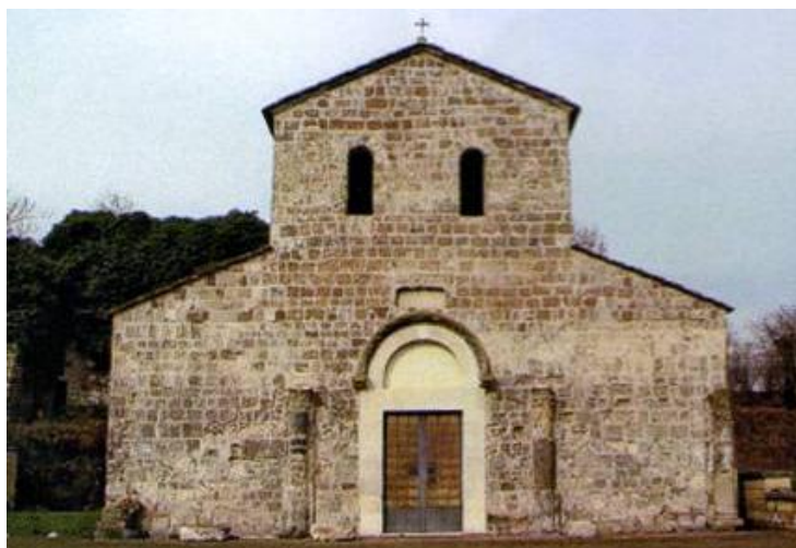
Figura 5. Teano, chiesa di San Paride ad Fontem, facciata
