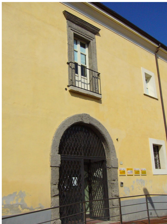
Figura 9. Falciano, palazzo vescovile. Prospetto su Via S. Gennaro in cui, forse, sono stati utilizzati elementi di preesistenti costruzioni che sorgevano nell'area della mensa vescovile.
