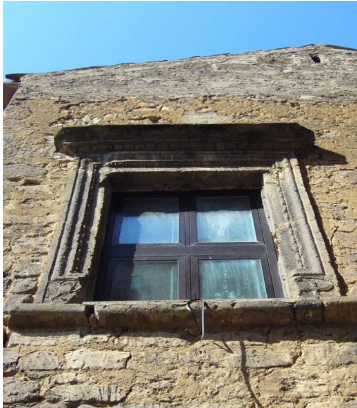
Figura 1. Casertavecchia, palazzo vescovile. Finestra con cornice classicheggiante in tufo pipernoide sul prospetto laterale di via Federico di Svevia.
