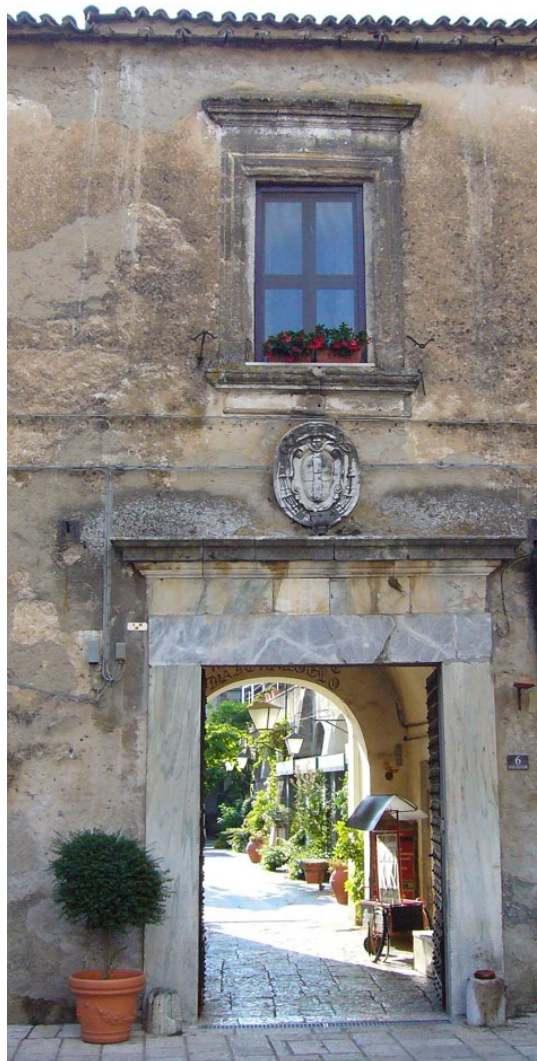
Figura 4. Casertavecchia, seminario vescovile (ora palazzo Mastrangelo), portale realizzato con materiale di spoglio (pedritti in marmo cipollino) sormontato dallo stemma del vescovo Diodato Gentile (1604-1616).
