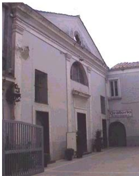
Foto n. 2: Chiesa di S. Simeone di Sala 25
